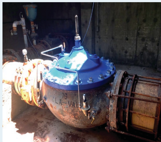
Приклад установки великого редуційного клапана тиску (PRV)
